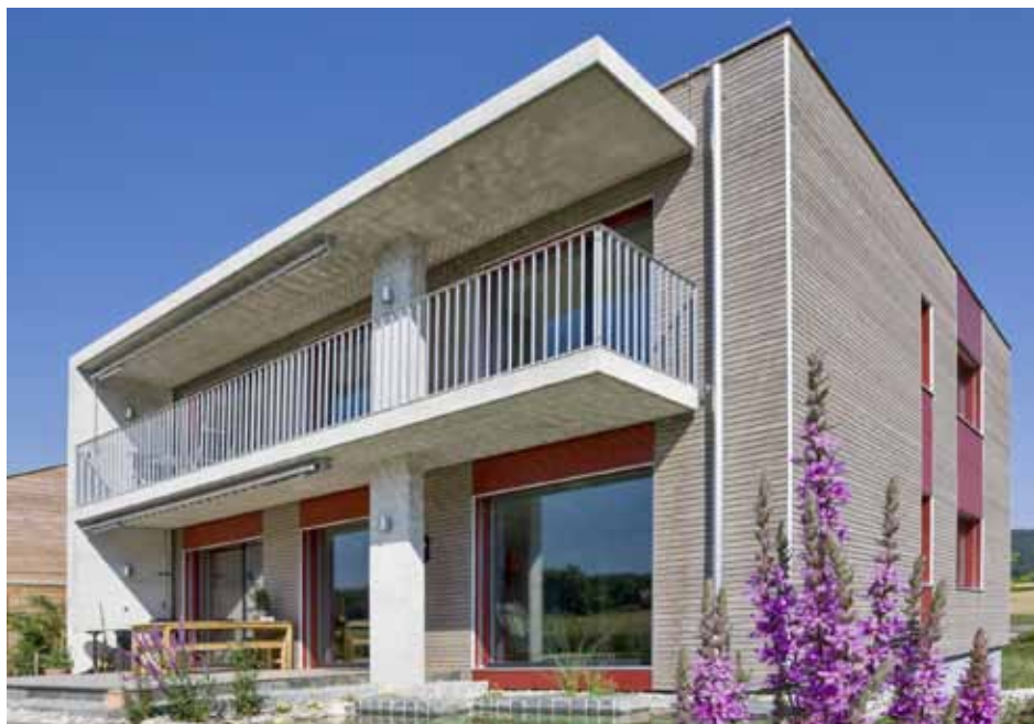
01 Grosse Fenster auf der Südseite ermöglichen passive Wärmenutzung (Foto: Verein Minergie)
