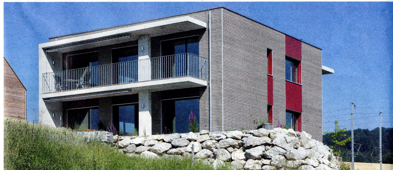
Idyllisch liegt das schweizweit erste Minergie-A-Haus in Rosshäusern. Die Gebäudehülle aus Holz wurde von Remund Holzbau gefertigt.
